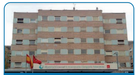
HOSPITAL UNIVERSITARIO GREGORIO MARAÑÓN Unidades Chiller (Madrid)
