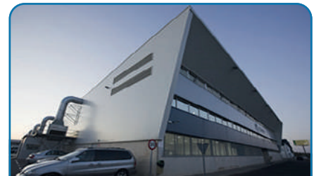
ALESTIS AERÓPOLIS Unidades VRF V4+ (35 Kw) (La Rinconada)
