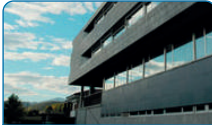
CENTRO GERIÁTRICO Unidades VRF V4+ (61,5 Kw) (Sabadell)
