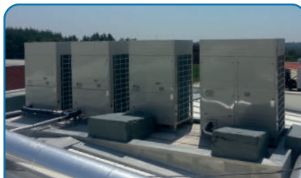
OLIVEIRA DO BAIRRO 2 Unidades VRF V4+ (33,5 Kw) (Portugal)
