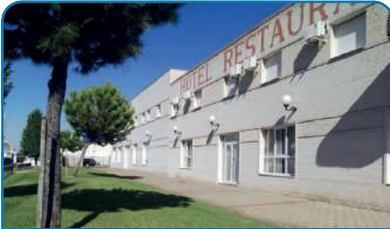
HOTEL "LA RABIDA" Unidades Split 1x1 + Columnas (Palos de la Frontera)
