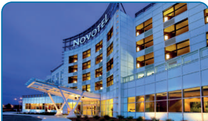
HOTEL NOVOTEL Unidades VRF V4+ (90 Kw) (Málaga)
